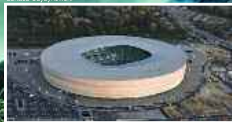
Grupa Górażdże dostarczała produkty budowlane na budowę trzech z czterech polskich stadionów, które będą arenami Mistrzostw Europy w Piłce Nożnej Euro 2012
